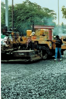
ऐशबाग के पास स्टैडियम के सामने सड़क की मरम्मत.
