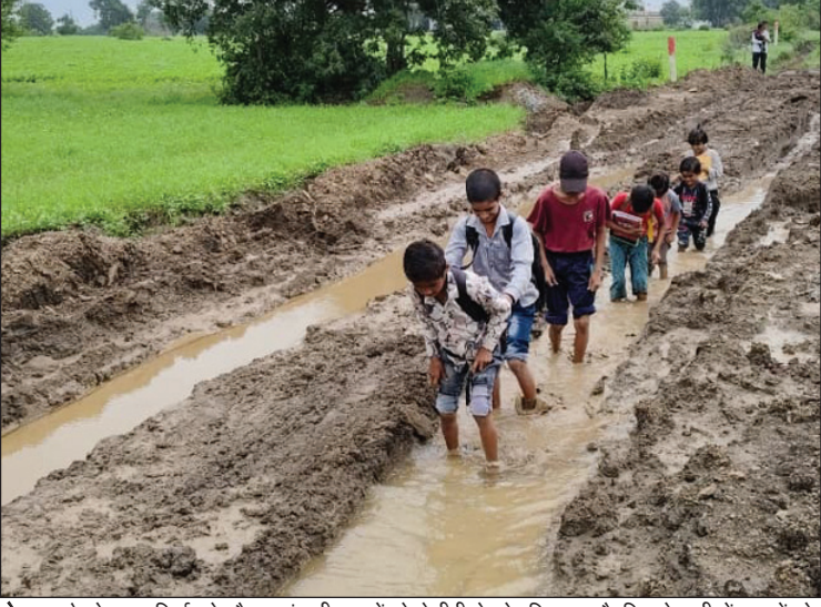
देरहा. रेलवे लाइन निर्माण के दौरान गांव की सड़कों को जेसीबी से खोद दिया गया है, जिससे ग्रामीणों व बच्चों को कीचड़ सहित खतरनाक नालियों के बीच से होकर स्कूल जाना पड़ रहा है. नतीजतन अब कई बच्चे स्कूल नहीं जा रहे.
